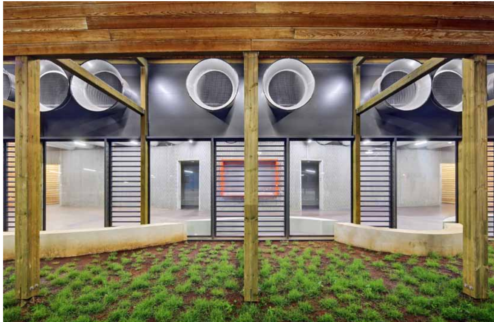
Très en vue Une partie de l'air est capté par des bouches localisées en pignon est.
