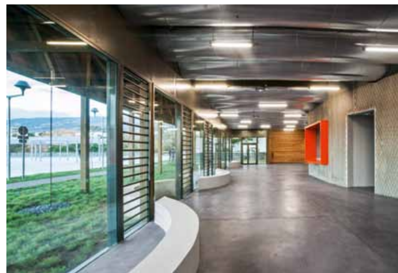
Bien frais Les gros tubes en acier inoxydable qui traversent le hall d'entrée, côté est, irriguent la partie supérieure des gradins.
