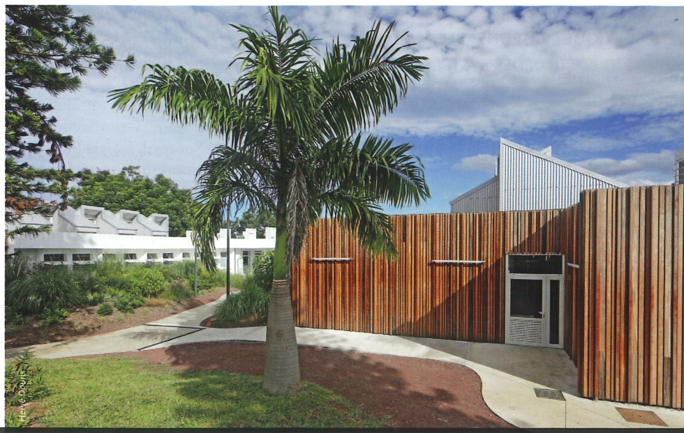
Les stratégies de ventilation sont adaptées aux contraintes des locaux desservis.
