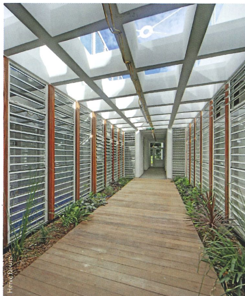
Le patio créé est source de lumière naturelle et permet une ventilation naturelle efficace.
